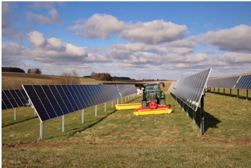
Abbildung 5: Beispiel einer single-axis Agri-PV Tracker-Anlage
