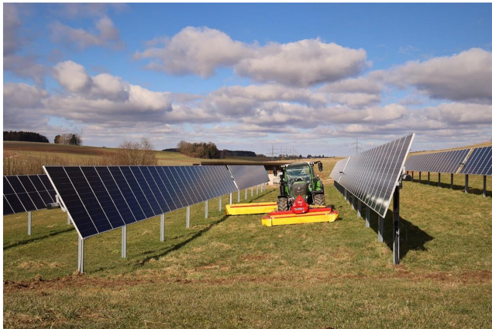
Abbildung 5: Beispiel einer single-axis Agri-PV Tracker-Anlage
