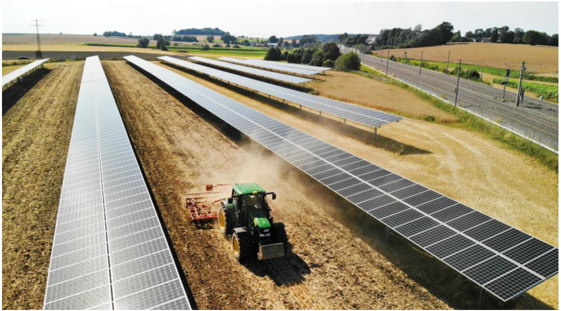
Abbildung 7: Agri-PV-Tracker-Anlage in Altheim
