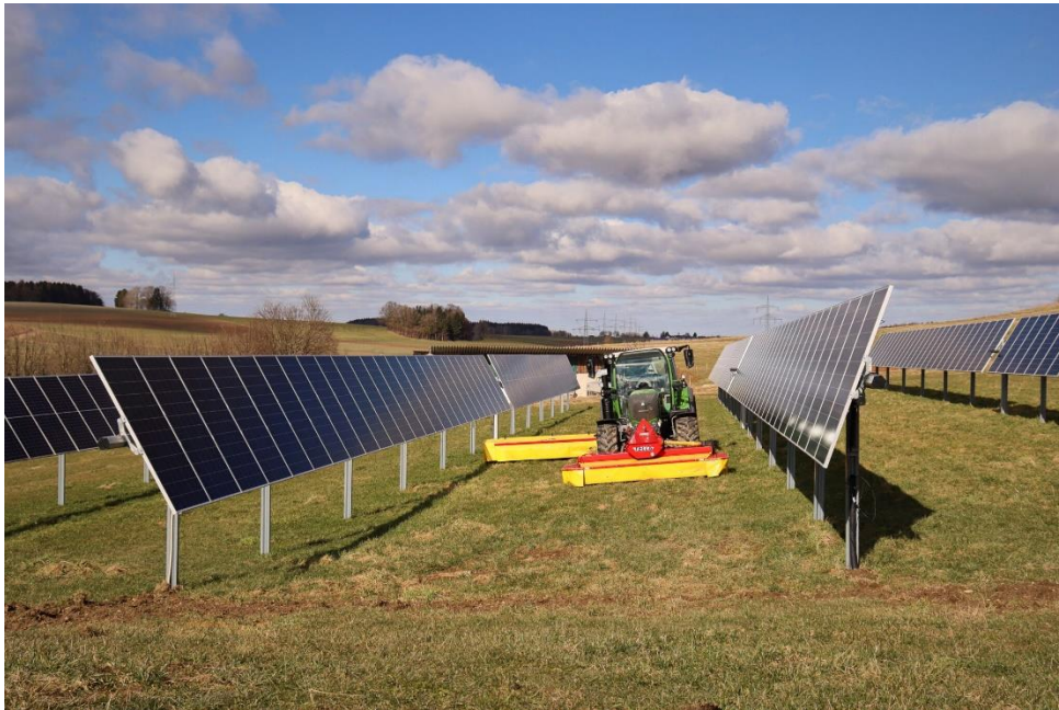
Abbildung 7: Beispiel einer single-axis Agri-PV Tracker-Anlage
