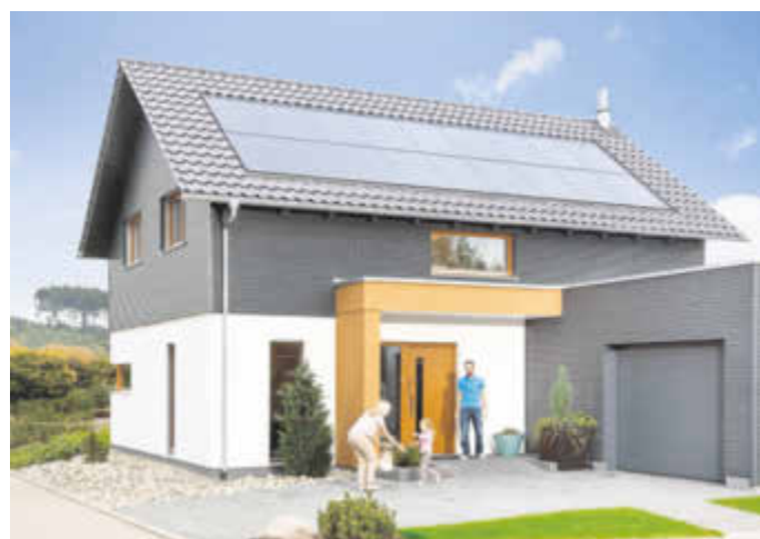
Die Kombination aus Photovoltaik-Indachlösung und intelligenter Haustechnik macht das Gebäude zu einem zukunftsweisenden Energieplus-Haus, das mehr umweltfreundlichen Solarstrom produziert als es benötigt. Foto: Schwörer Haus/interPress
